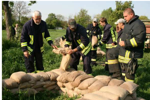
Bau einer Quellkade
