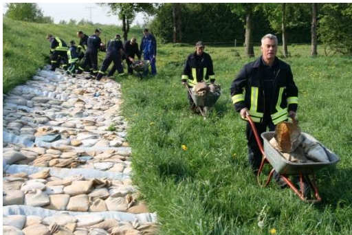
Abtransport der Sandsäcke
